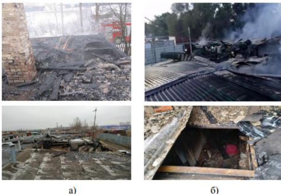
1-сурет-отқа төзімділігі III-V дәрежелі тұрғын үйлердегі өрт кезінде жабындардағы күйіктер а-өртті жойғаннан кейінгі түрі; Б-өрт сөндіру кезінде ашу
