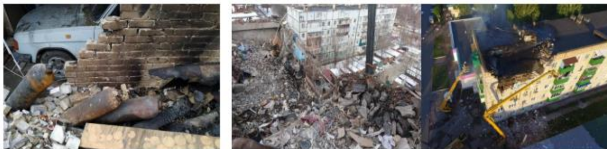
3-сурет-ғимарат конструкцияларының құлау мысалдары: а-сыртқы қабырға; б-ғимараттың сыртқы және ішкі конструкциялары
