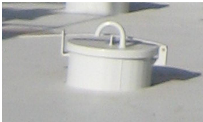
Рисунок 2 – Общий вид люка короба двудечной плавающей крыши РВСПК
