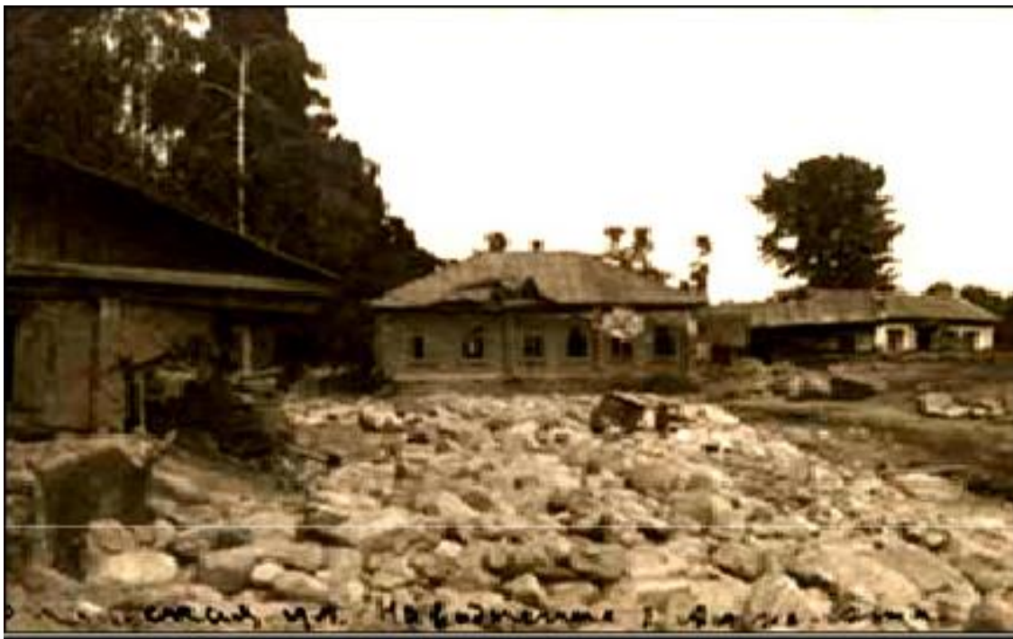
Рисунок - 4.3.2. Сель 1921 г. разрушения в г. Алма-Ата
