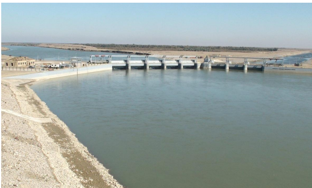
Рисунок - 36. Коксарайский противопаводковый контррегулятор
