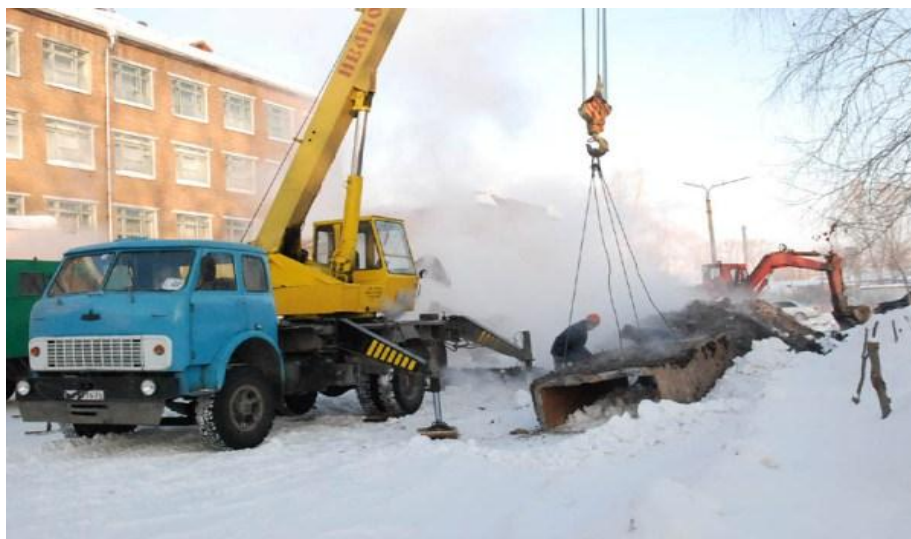
Рисунок – 77. Ликвидация последствий аварии на системах теплоснабжения в г. Приозерске
