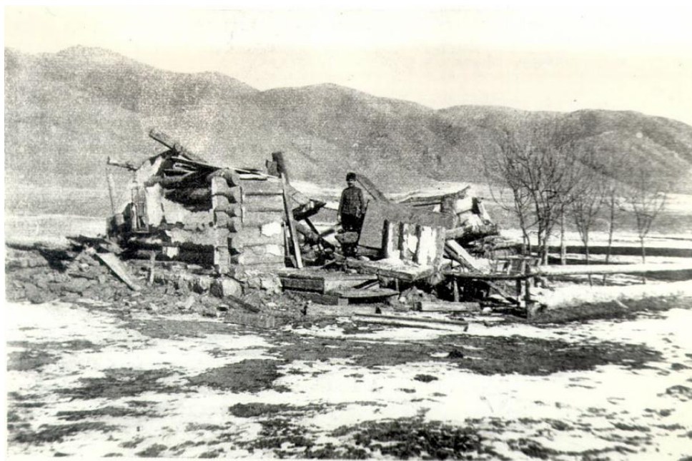
Рисунок - 10. Последствия Кеминского землетрясения 1911 г.
