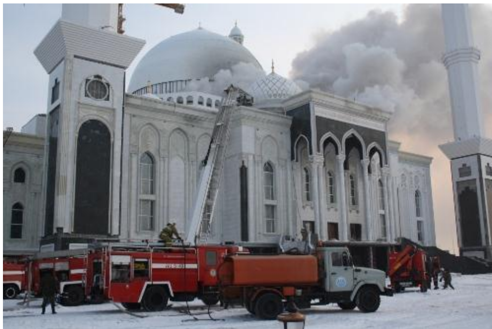
Рисунок – 60. Пожар в строящейся мечети г. Астана
