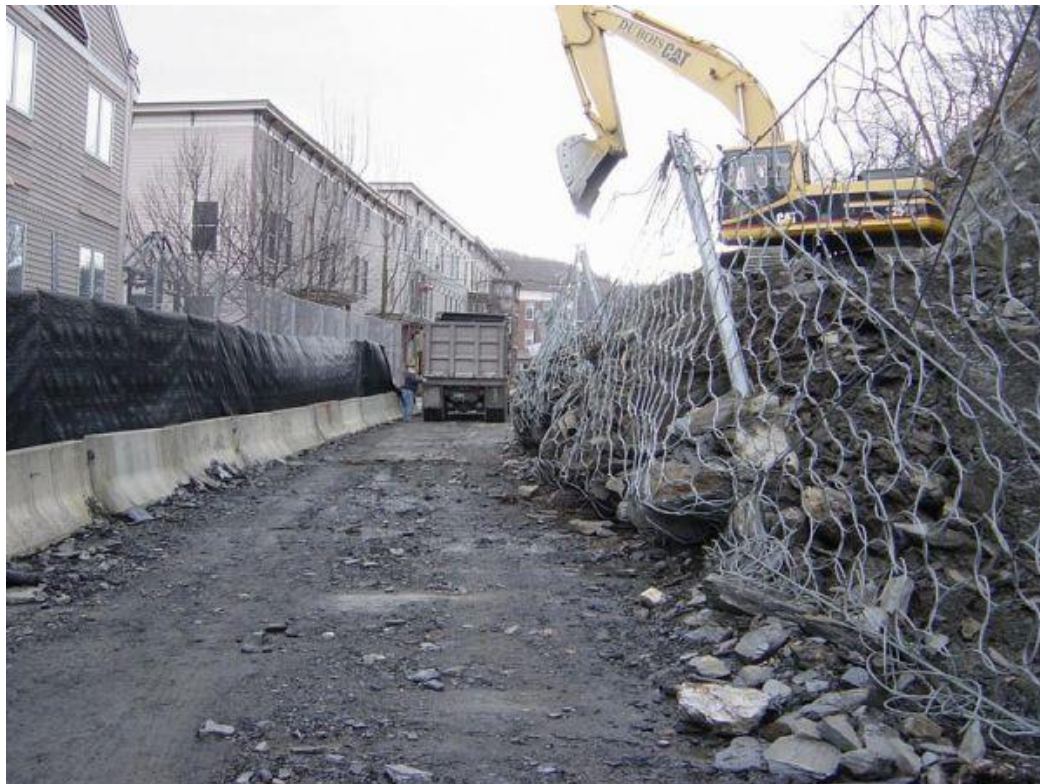
Рисунок - 17. Схема действия кольчужной сети.
