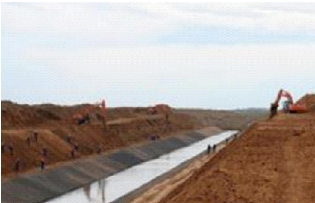
Рисунок 33 - Строительство защитной дамбы в с. Тамерлановка Южно-Казахстанской области
