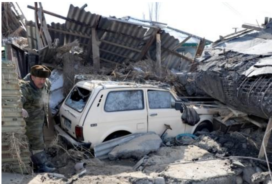
Рисунок 30 - Последствия аварии на Кызылагашском водохранилище
