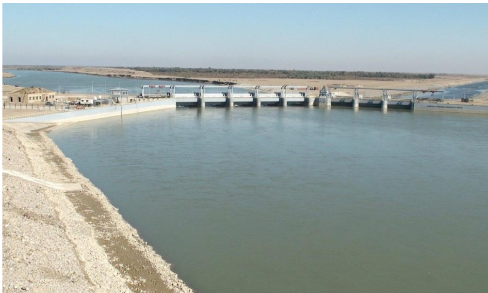
Рисунок 34 –Коксарайский противопаводковый контррегулятор
