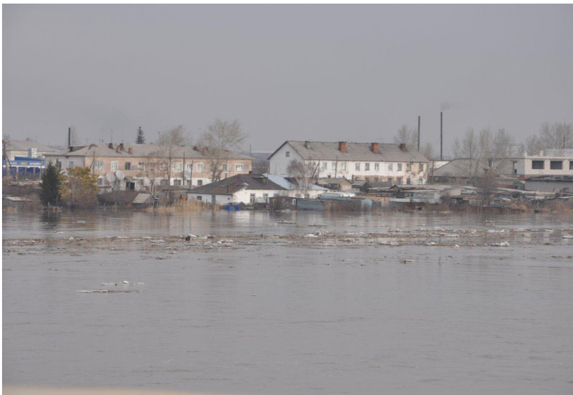
Рисунок 15 - Последствия наводнения в г. Атбасар 2014 год
