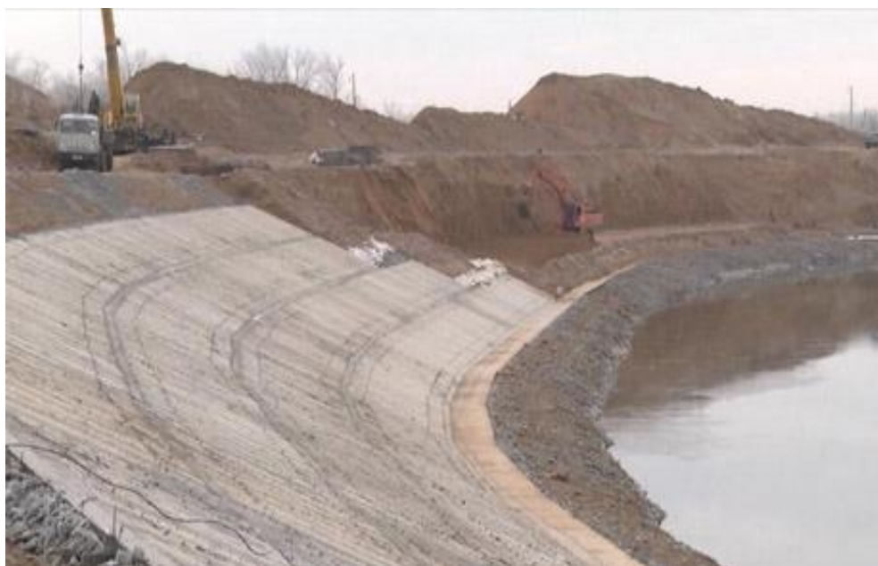
Рисунок 36 - Берегоукрепительные работы на реке Урал
