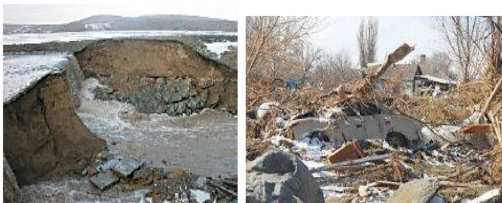
Рисунок 3. Прорыв плотины у п.Кзыл-Агаш
