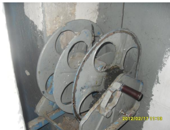
Рисунок 2 – Внешний вид лебедки для подъема рукавов
